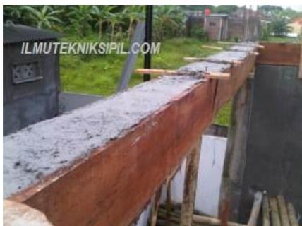
**Gambar 1** – Bekisting konvensional dengan bahan Triplek yang telah diisi dengan beton [4]
