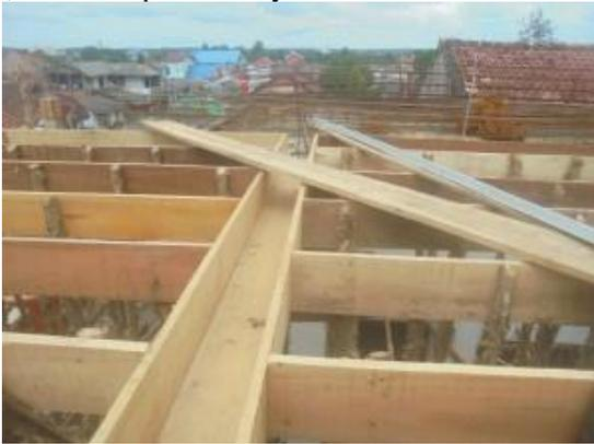
**Gambar 4** – Bekisting terdiri dari 2 sisi tinggi dan 1 sisi lebar [7]
