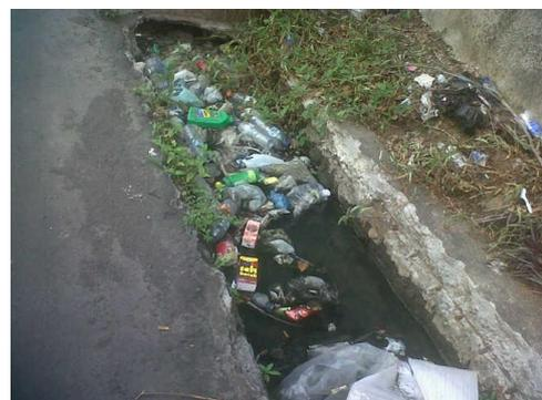
Gambar 3 Saluran drainase permukaan yang tersumbat (sumber : <http://manadoline.com/warga-pinaesaan-belum-sadar-buktinya-drainase-ini-tersumbat/> diakses pada 5 Desember 2015 pukul 13.33 GMT+7)
